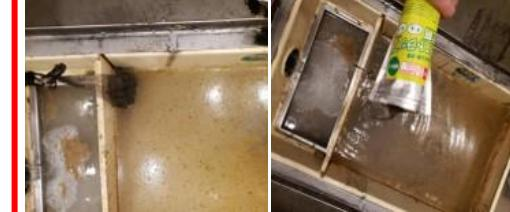
2槽目に浄化剤をセットし、袋に残ってる浄化剤も水ですすいで全て2槽目にいれます。
