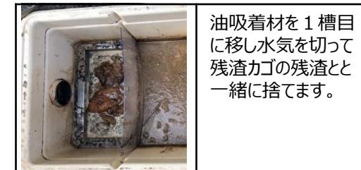
油吸着材を1槽目に移し水気を切って残渣カゴの残渣と一緒に捨てます。
