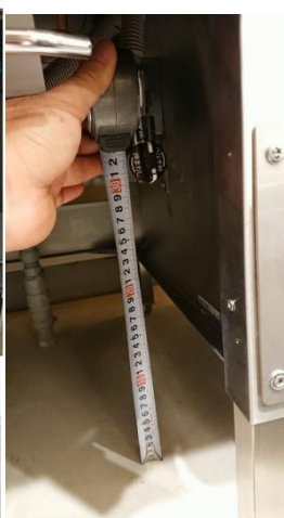
コック下端～床までの有効寸法 30cm必要
