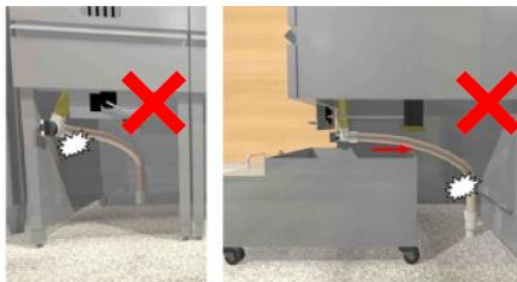
油ろ過機・油受けを入るとガスホースに接触する可能性がある。(参考写真)
